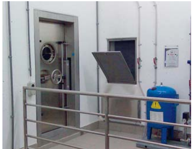
6 Räume mit erhöhten Radonkonzentrationen werden luftdicht verschlossen.
