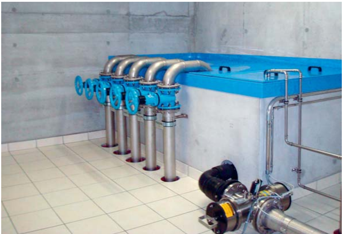
4 und 5 Radon wird mit speziellen Einrichtungen aus dem Wasser entgast.
